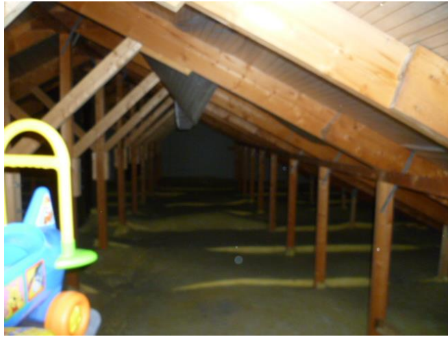
Loftet slik det ser ut uten lagring, med en seksjoneringsvegg imot. Loftet var nok opprinnelig ikke tenkt til lagring.
